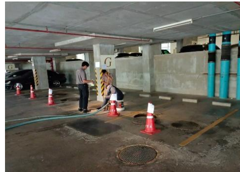
รูปที่ 49 การสูบน้ำออกจากระบบบำบัดน้ำเสีย
