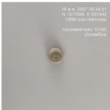
รูปที่ 31 เครื่องตรวจจับความร้อนและเครื่องตรวจจับควัน
