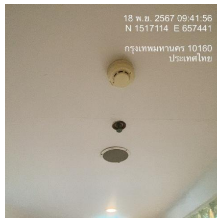
รูปที่ 31 เครื่องตรวจจับความร้อนและเครื่องตรวจจับควัน
