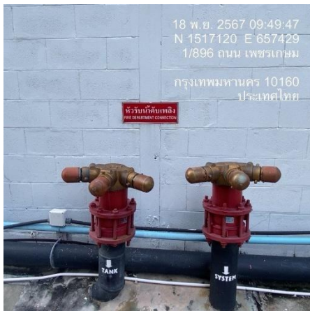
รูปที่ 27 ห้รับน้ำดับเพลิง
